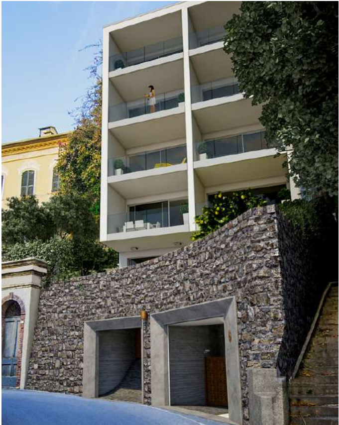
Esterni fronte principale
