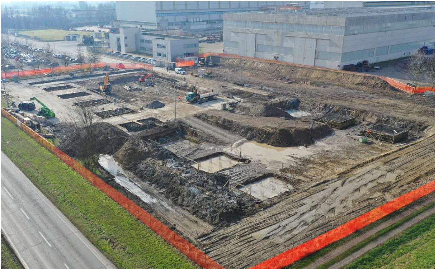
Foto dal drone opere di fondazione
