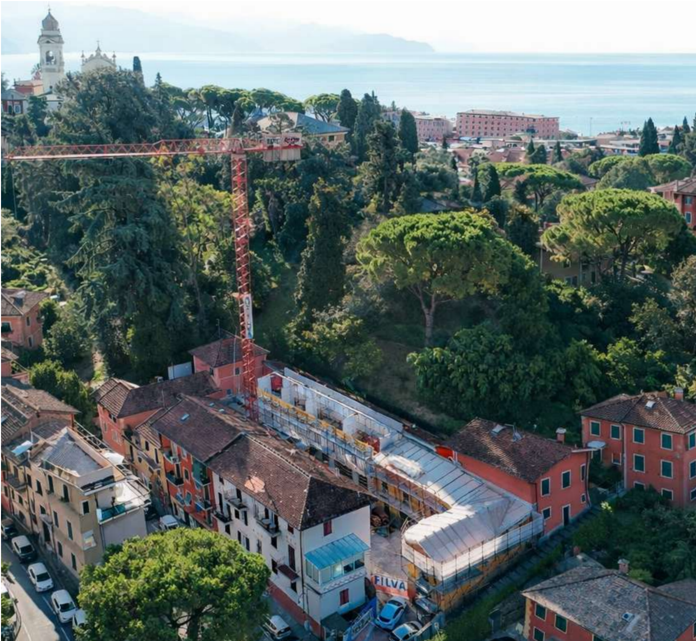
Vista dall'alto del cantiere
