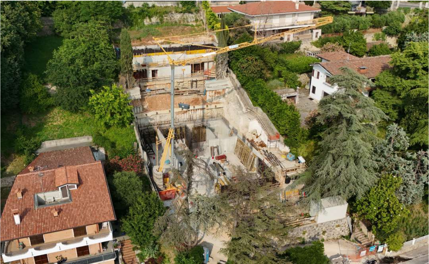
Avanzamento dei lavori giugno 2025
