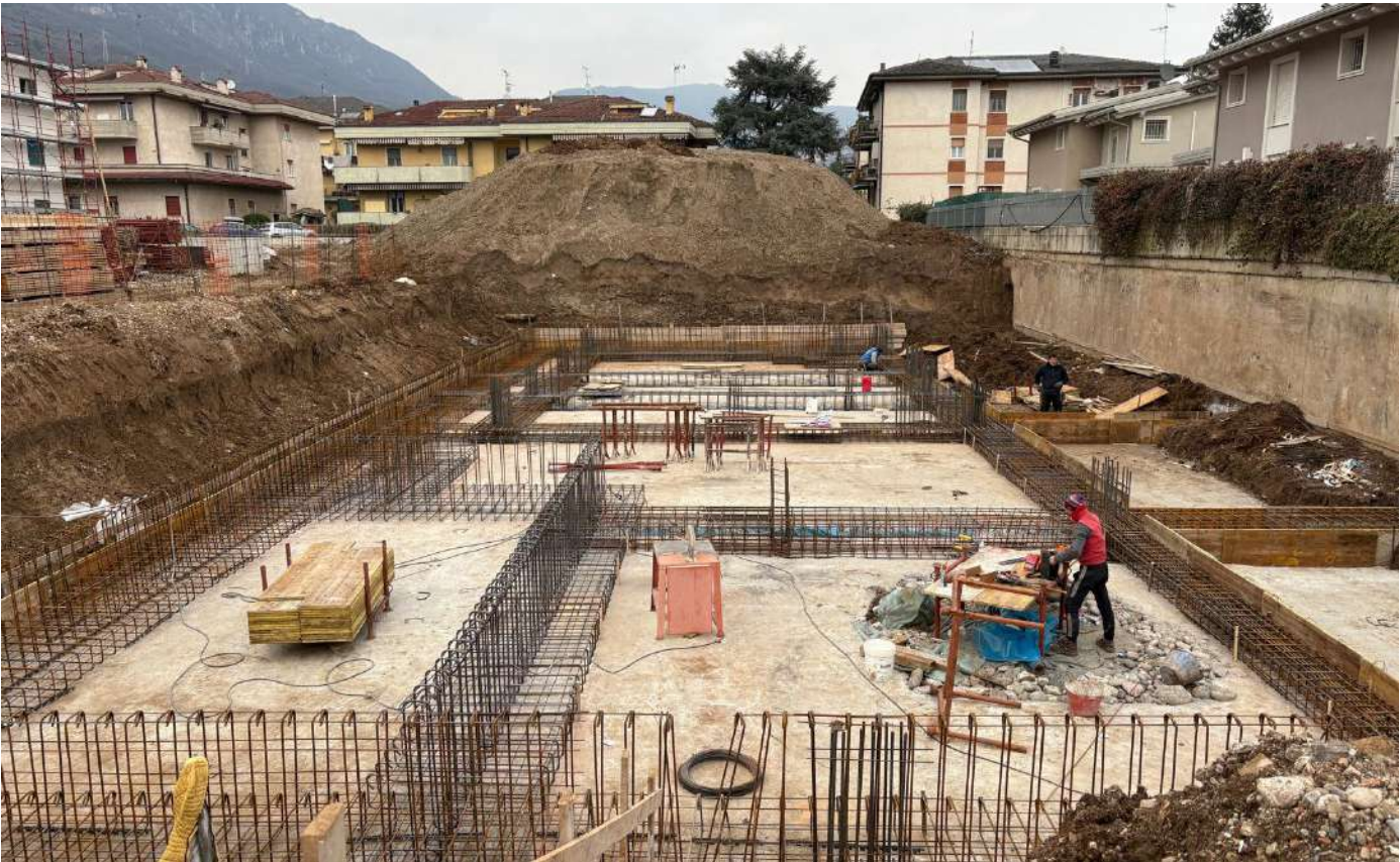
Avanzamento lavori febbraio 2026 – armatura fondazioni
