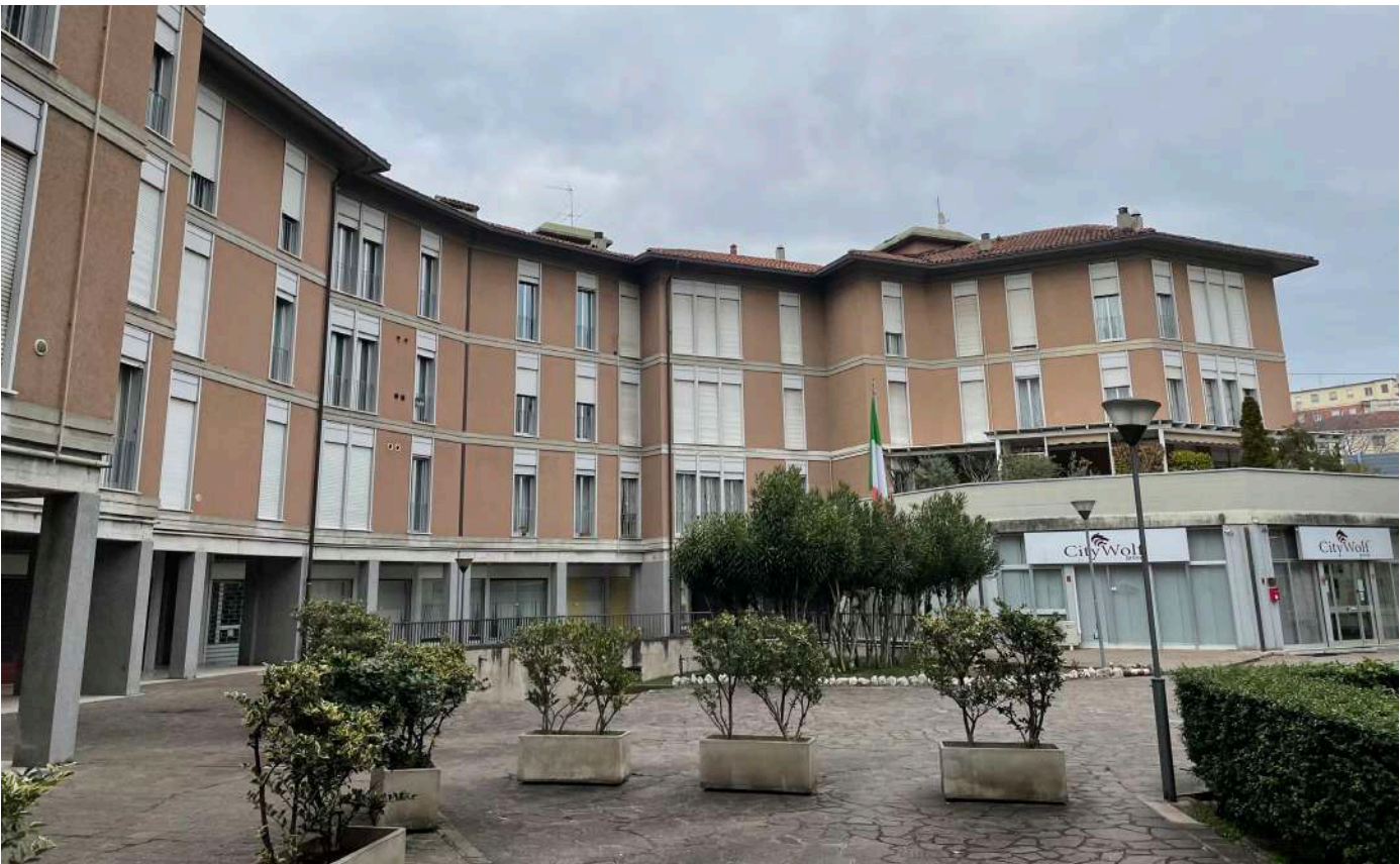
CONDOMINIO PARCO MARTINONI – Opere ultimate
