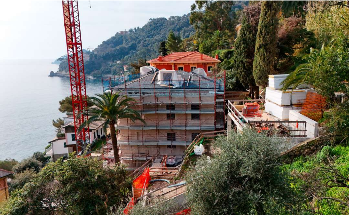
Avanzamento dei lavori - cerchiatura portale zona pranzo
