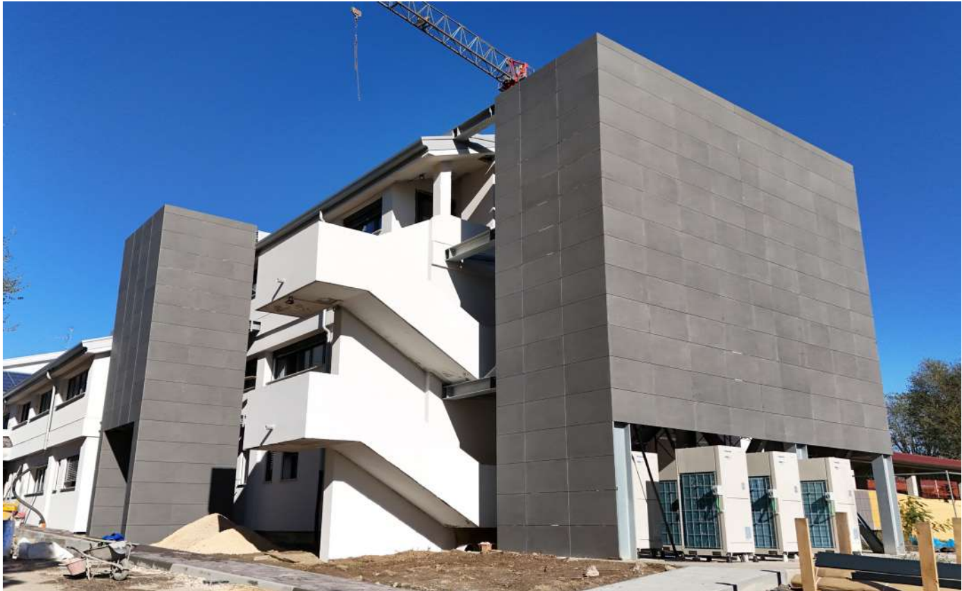
Avanzamento dei lavori – rivestimento in gres a copertura dei controventi sismici
