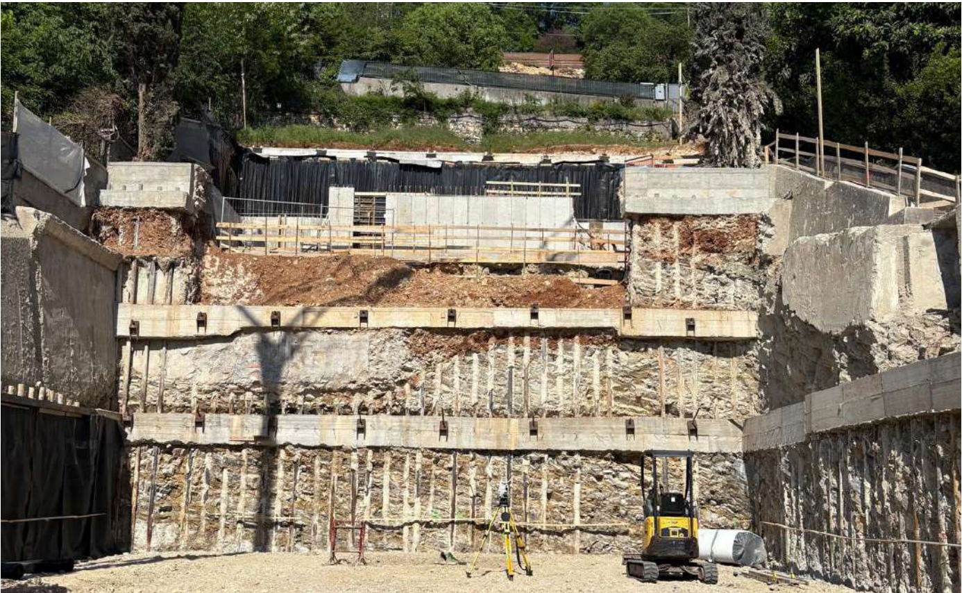
Avanzamento dei lavori maggio 2025 – opere di sostegno provvisorie e scavo
