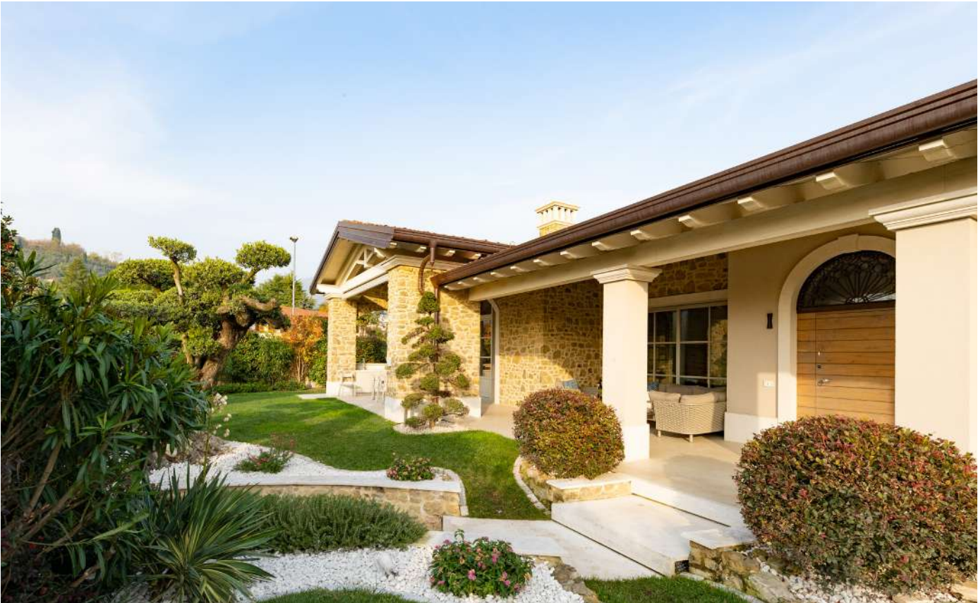
Viste esterne opere ultimate - ingresso
