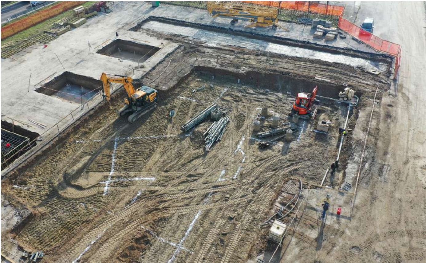
Scavo per opere di fondazione
