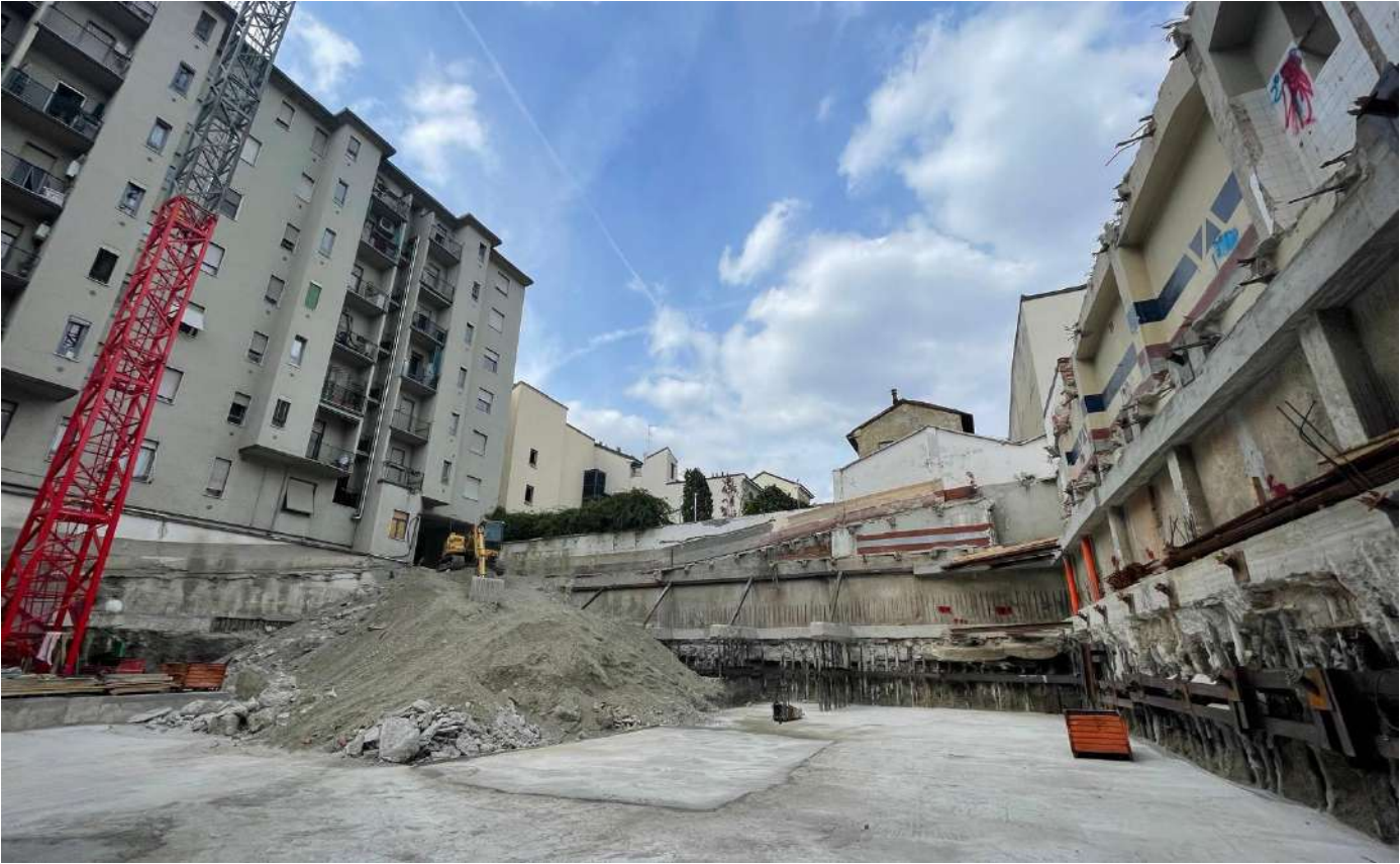
Scavo iniziale e opere di palificazione
