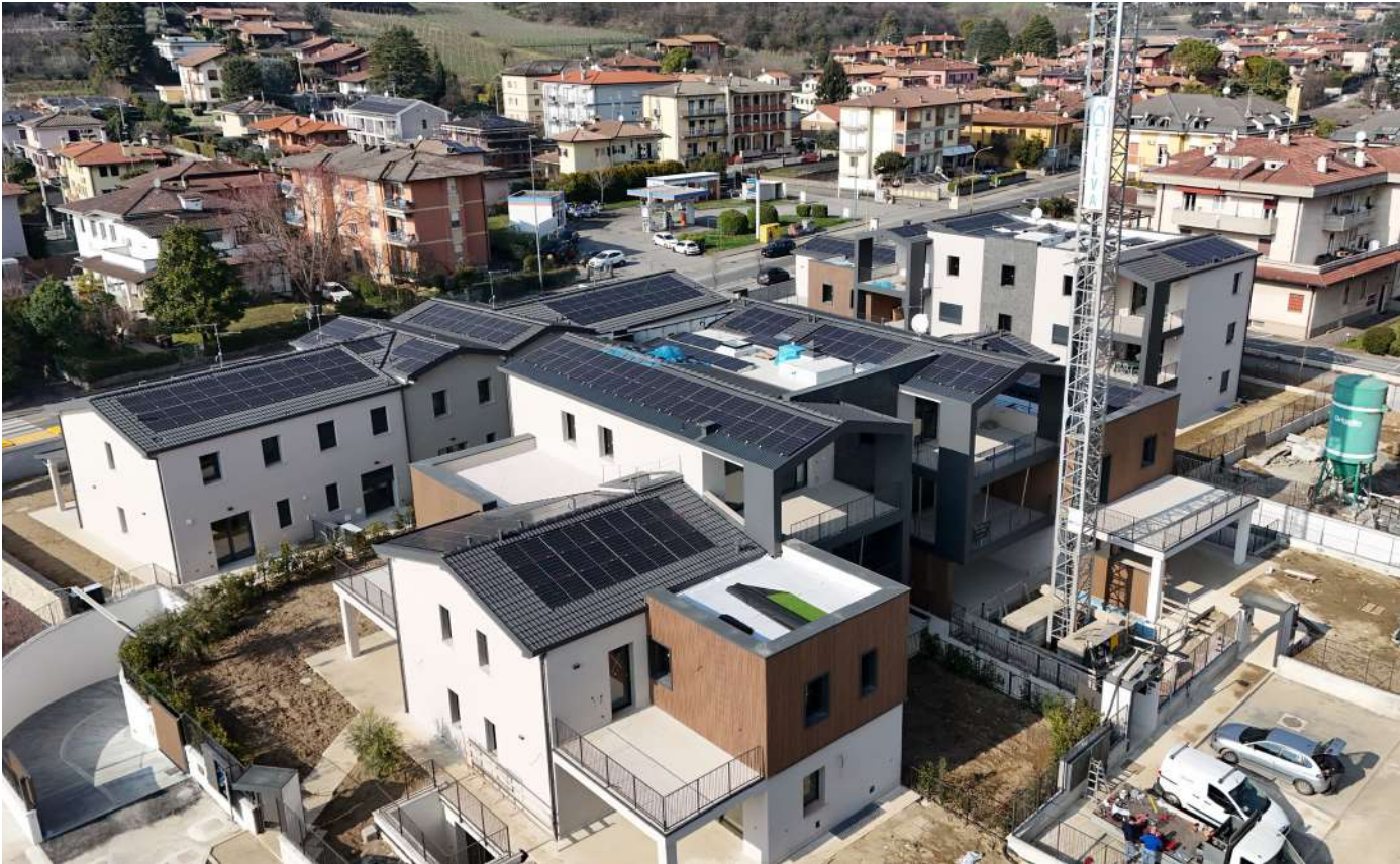
Stato di avanzamento del Residence – febbraio 2026
