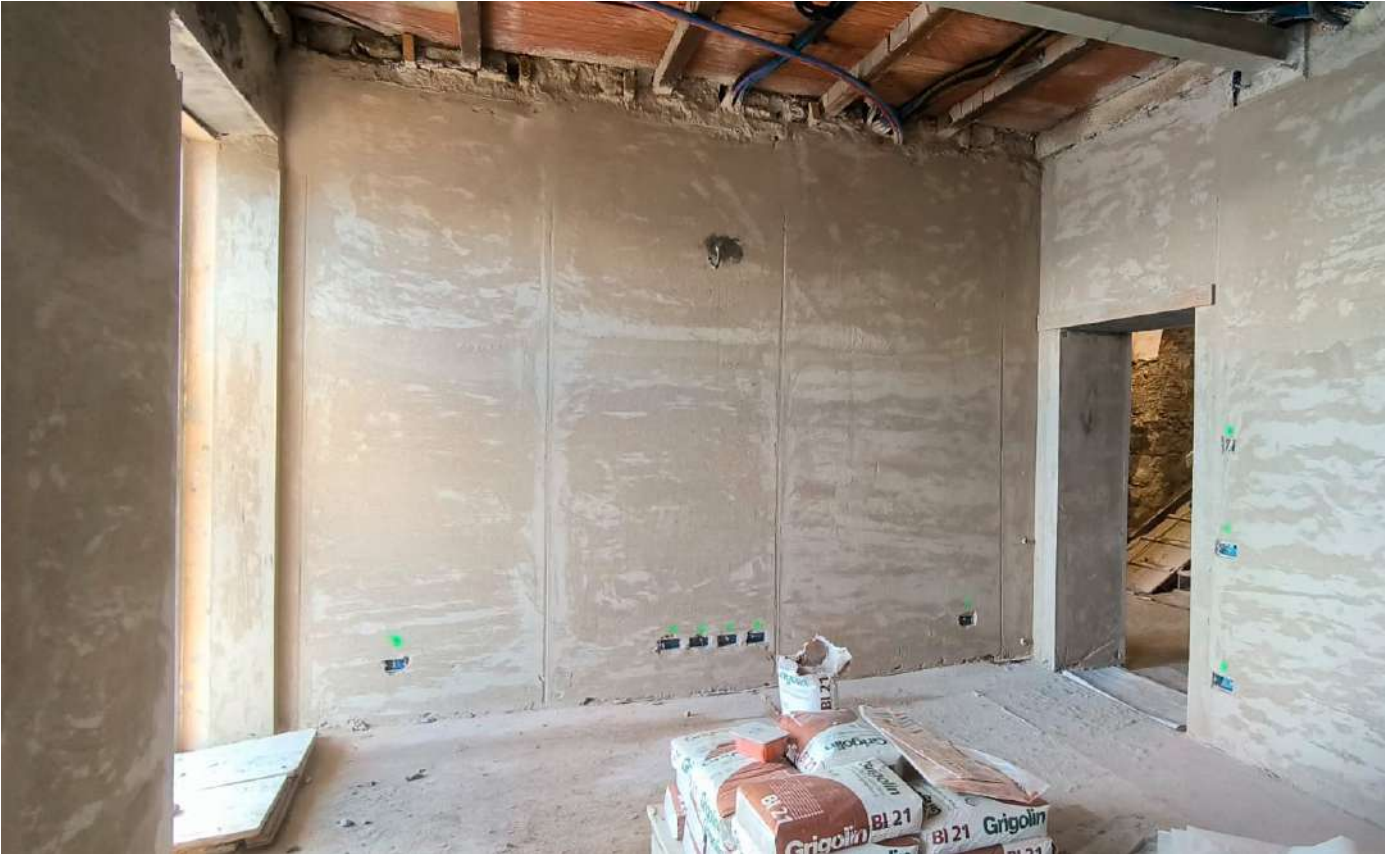
Realizzazione intonaco interno
