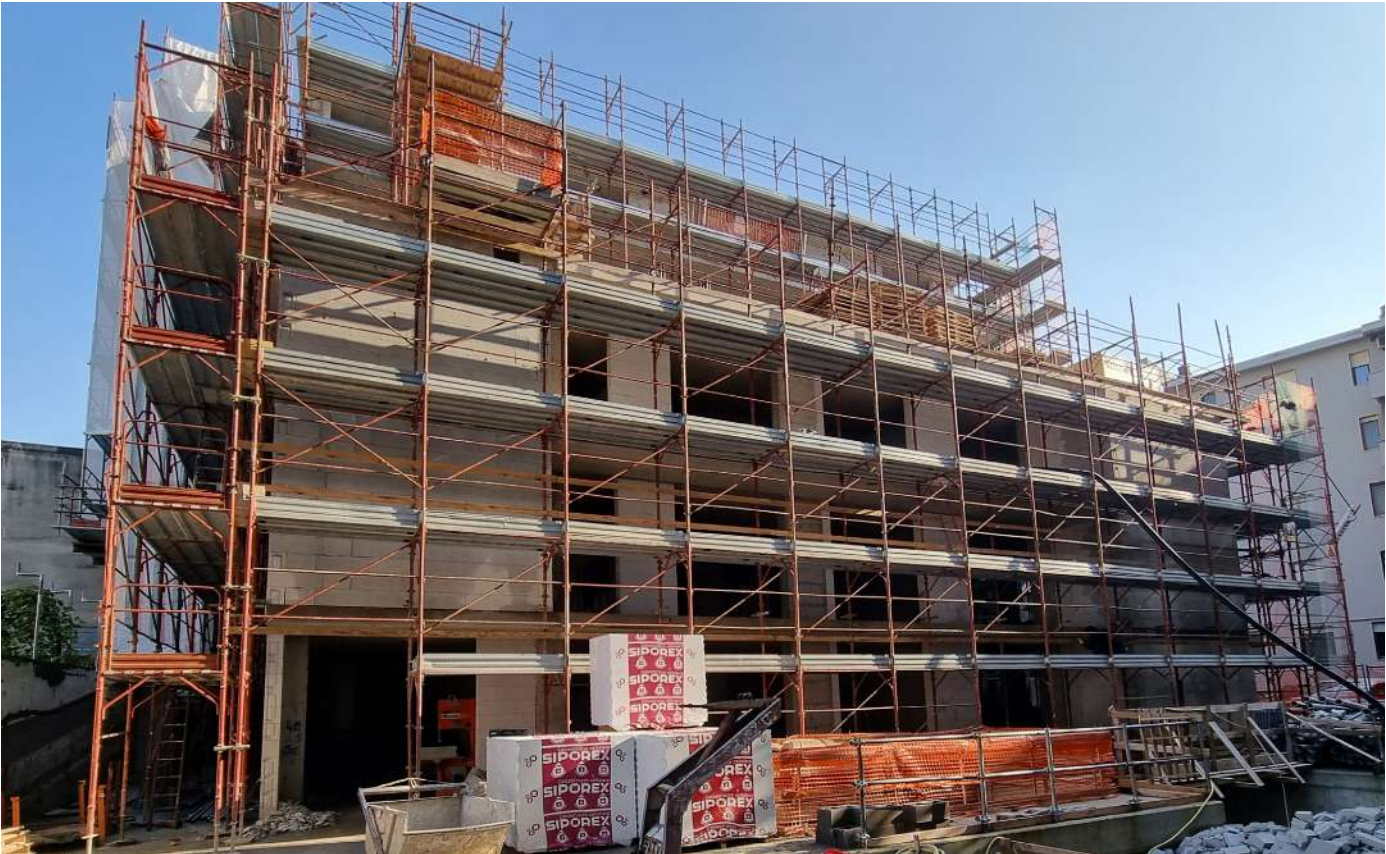
Opere in fase di realizzazione
