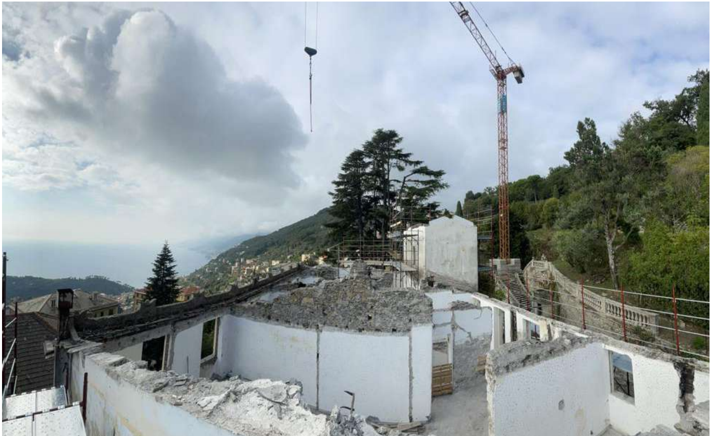
Stato del cantiere ottobre 2023
