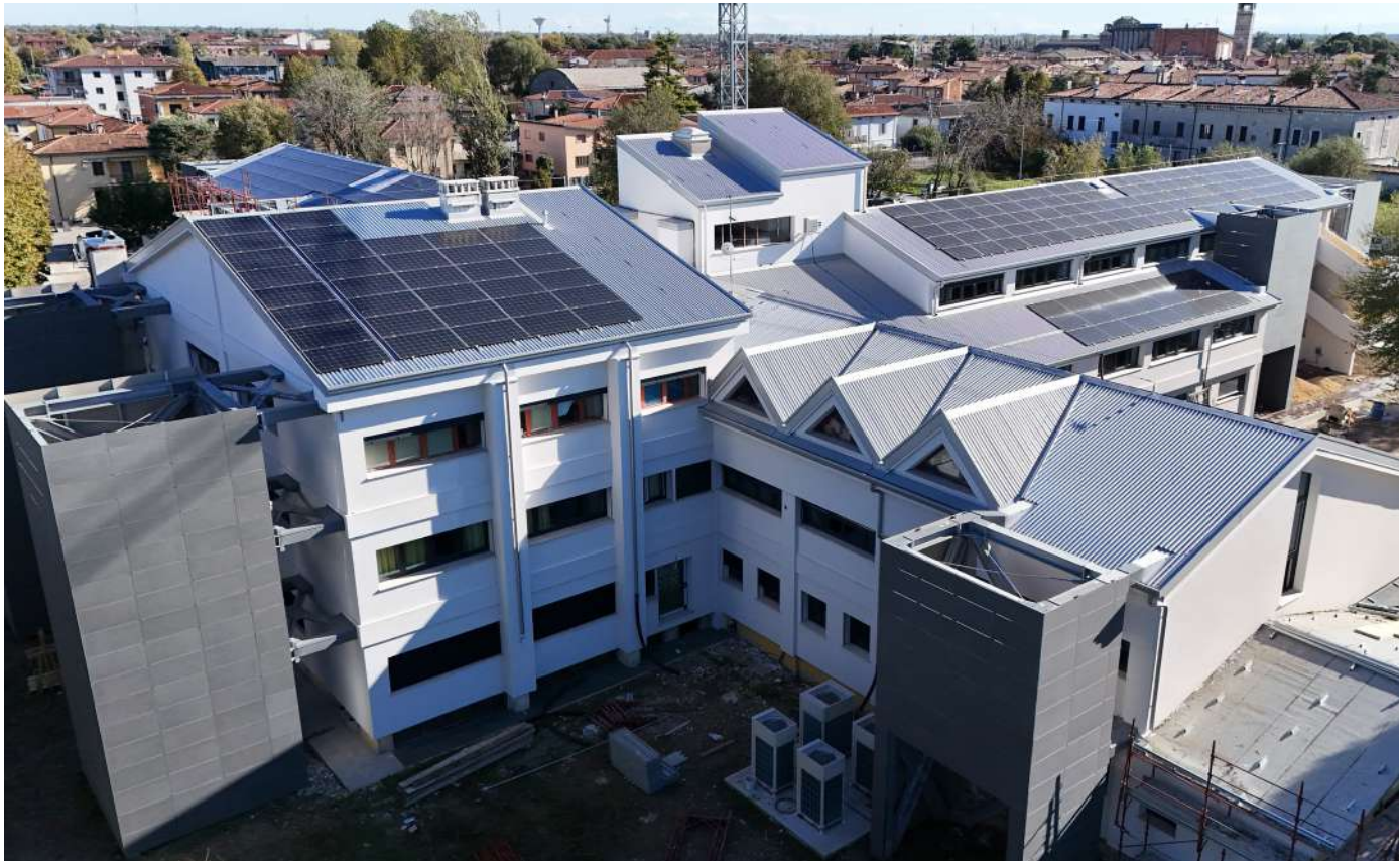
Avanzamento dei lavori
