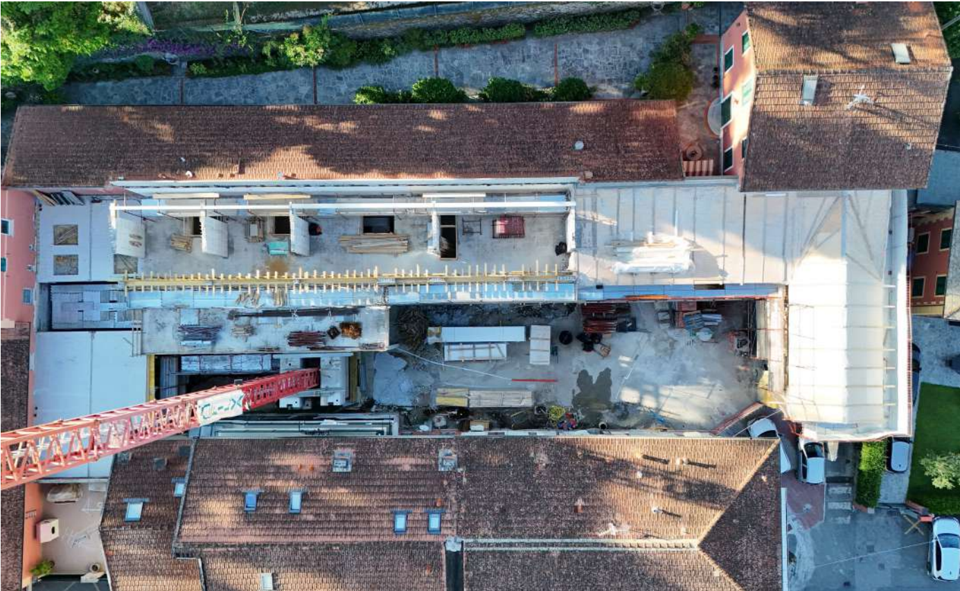
Vista dall'alto del cantiere
