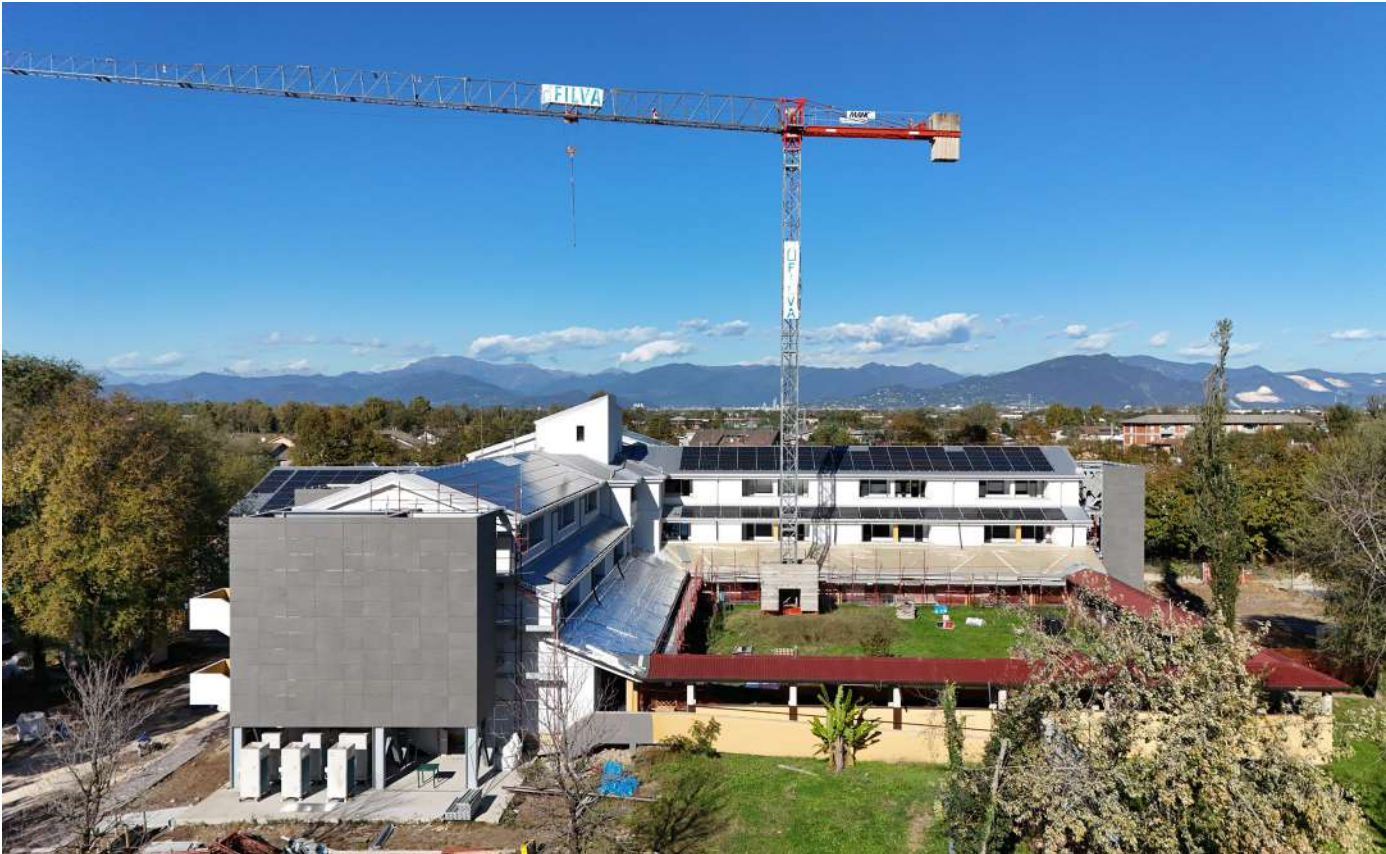
Avanzamento dei lavori – corte interna
