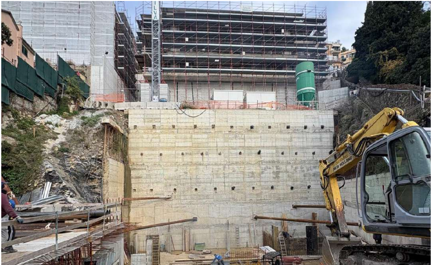
Scavo e opere di sostegno provvisore -zona autorimessa
