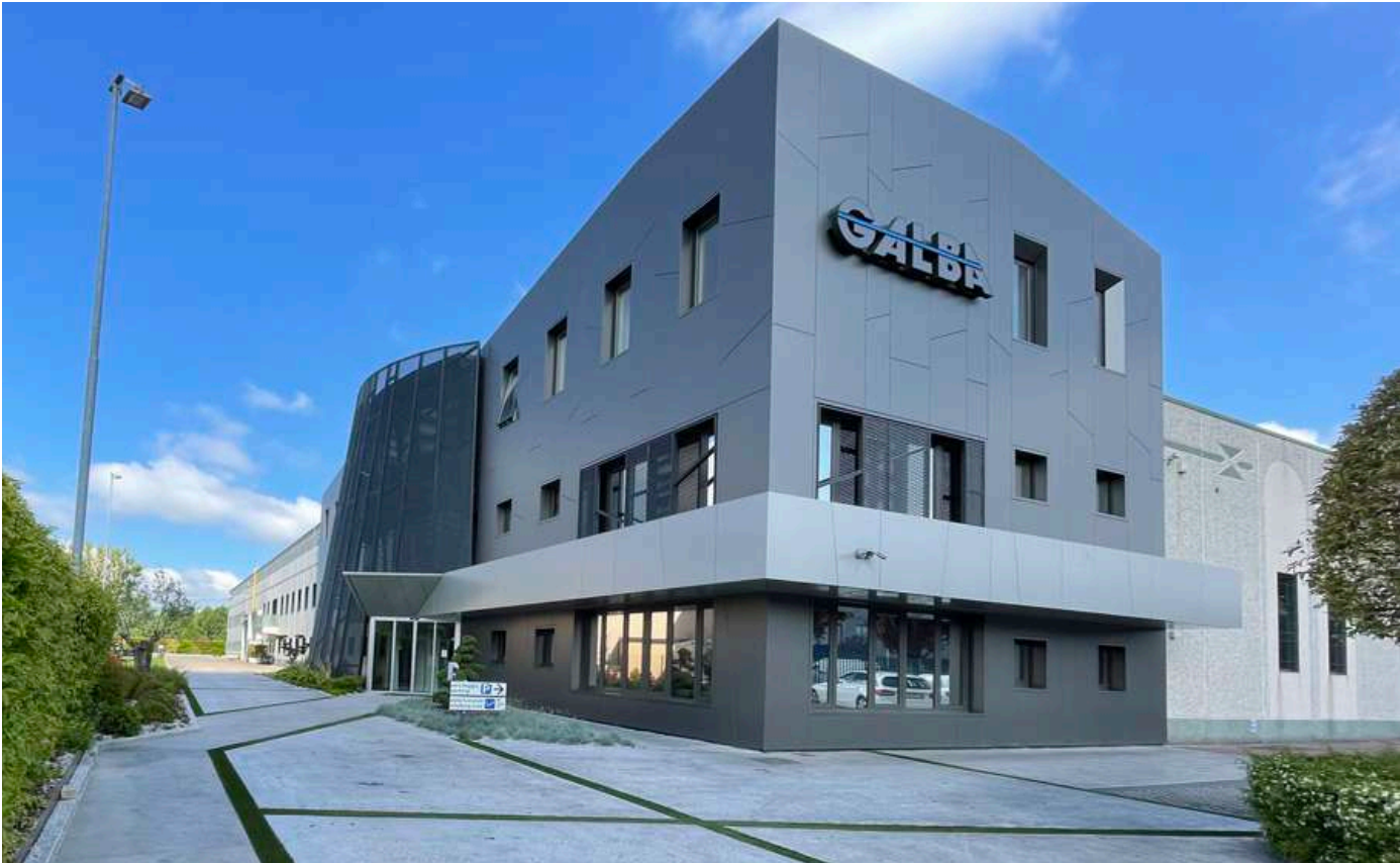
Opere esterne ultimate SOPRALZO GALBA
