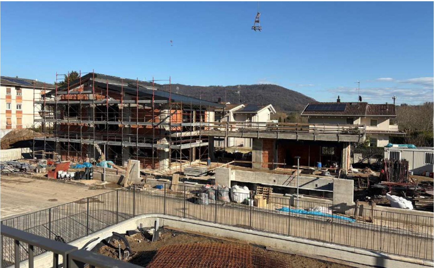
Avanzamento lavori gennaio 2026
