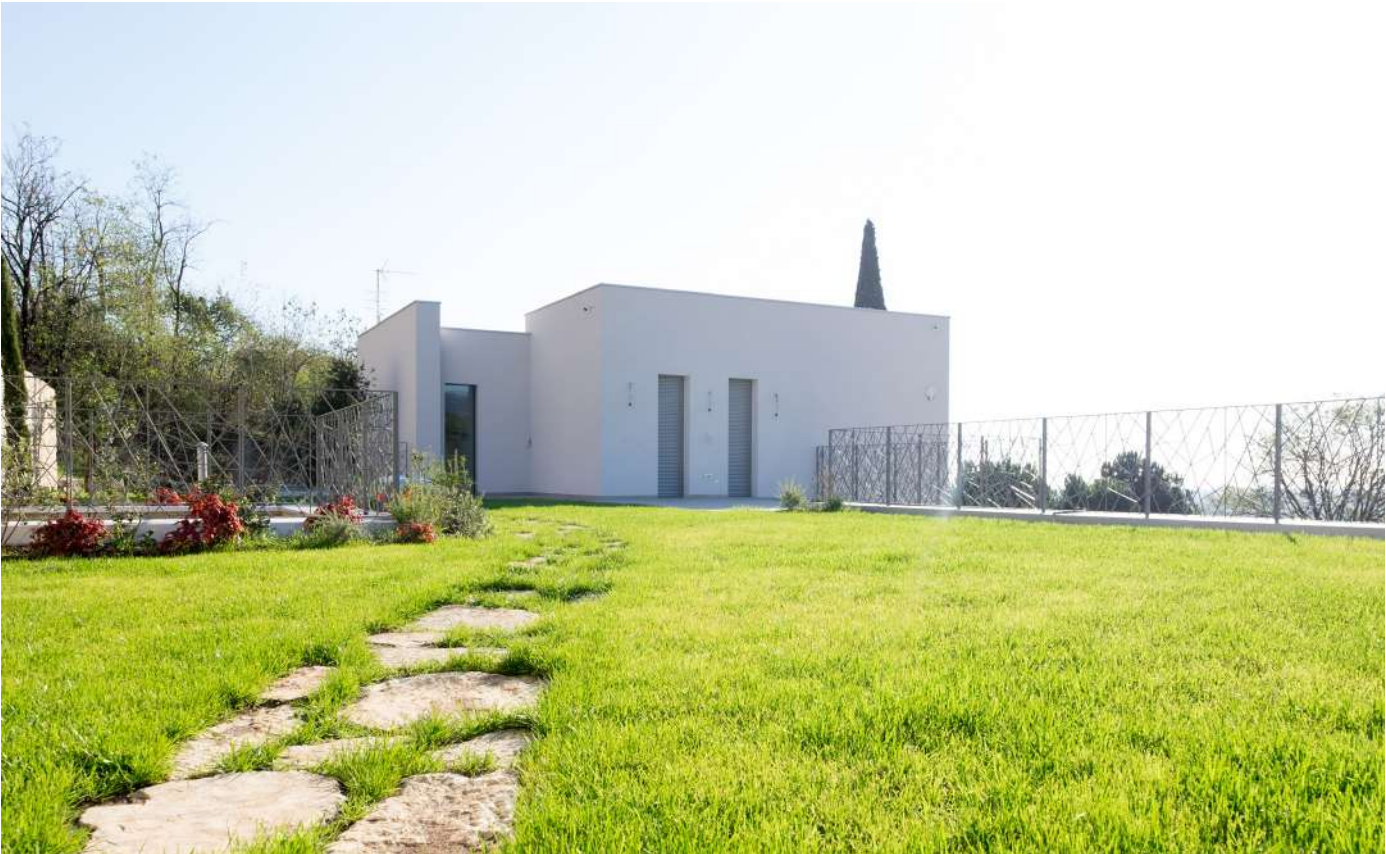
Giardino pensile a copertura di cucina e sala pranzo
