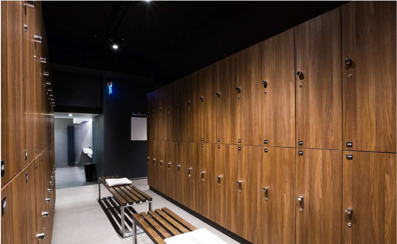
Opere interne per ristrutturazione piscina
