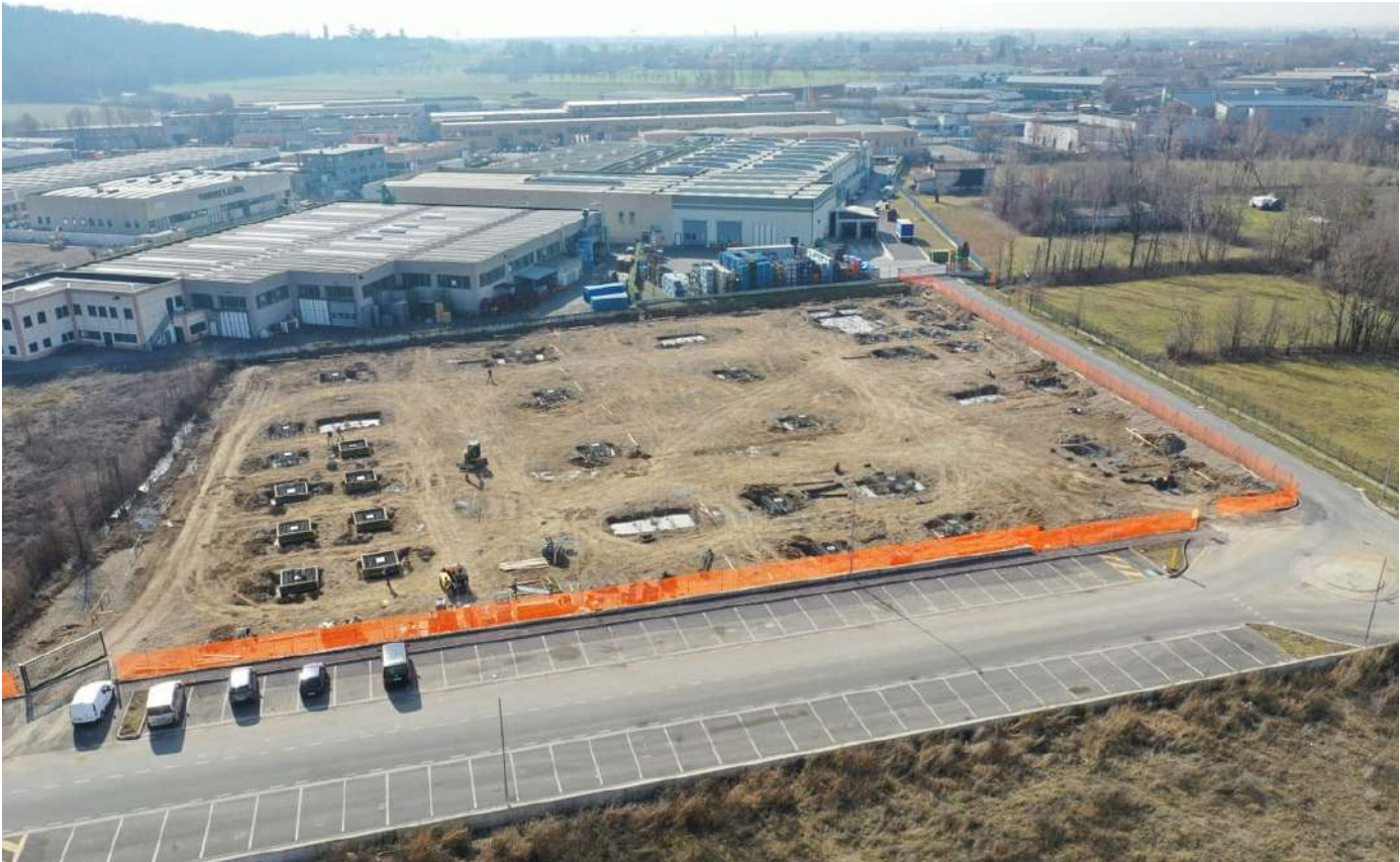
Vista area delle opere edili di fondazione
