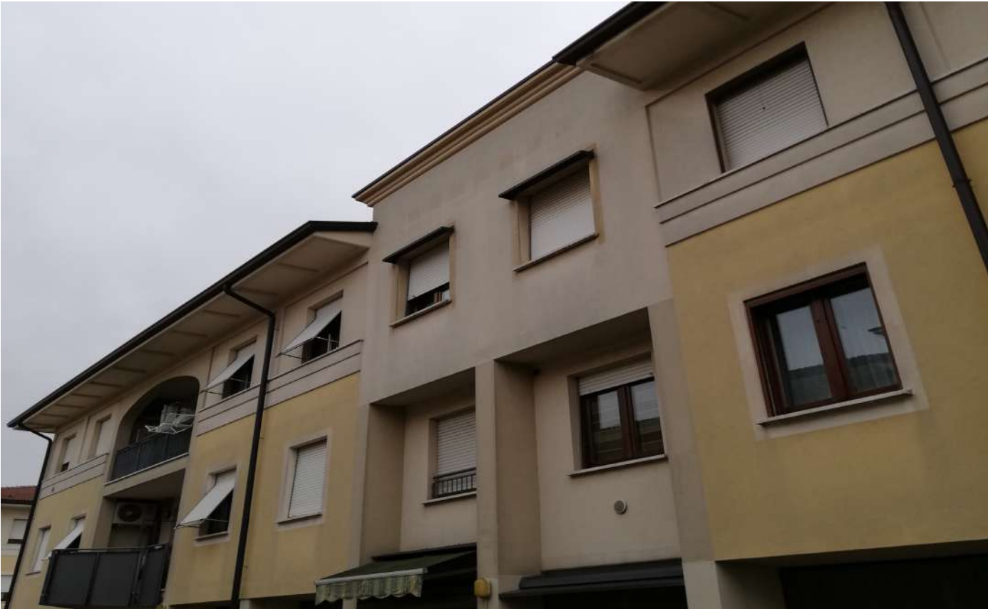
CONDOMINIO LE TORRETTE prima dell'intervento edilizio
