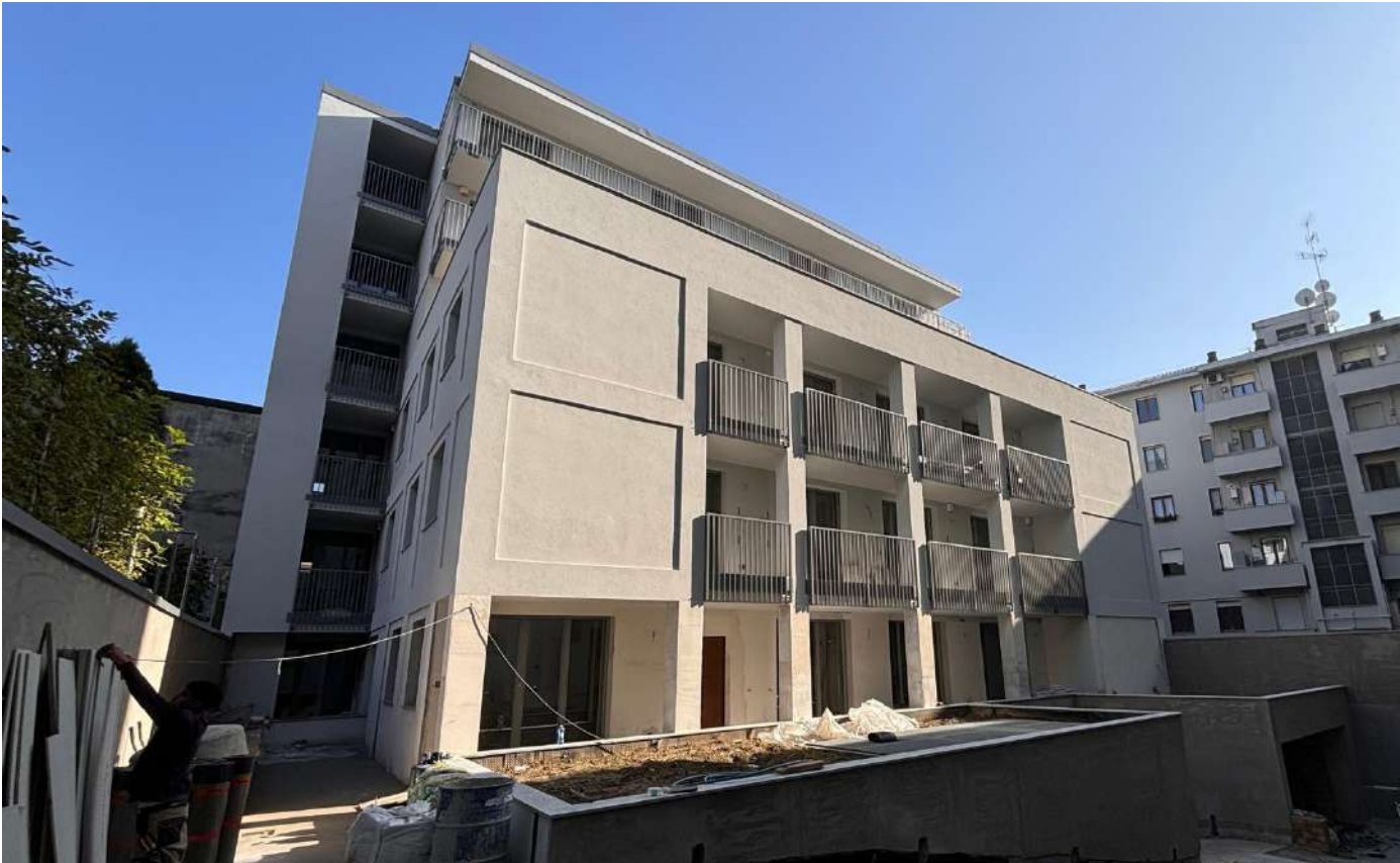
Avanzamento dei lavori
