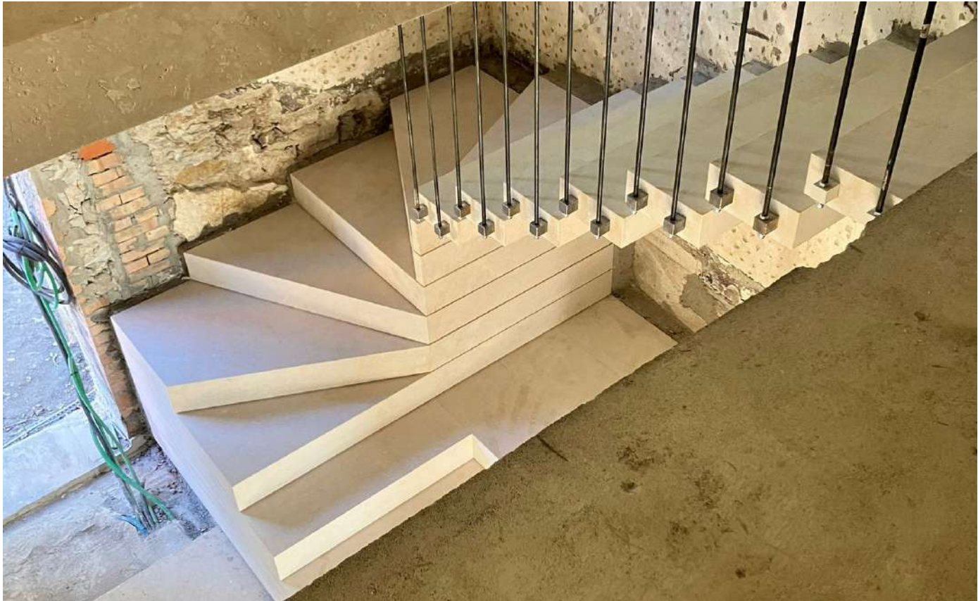
Dettaglio scala interna
