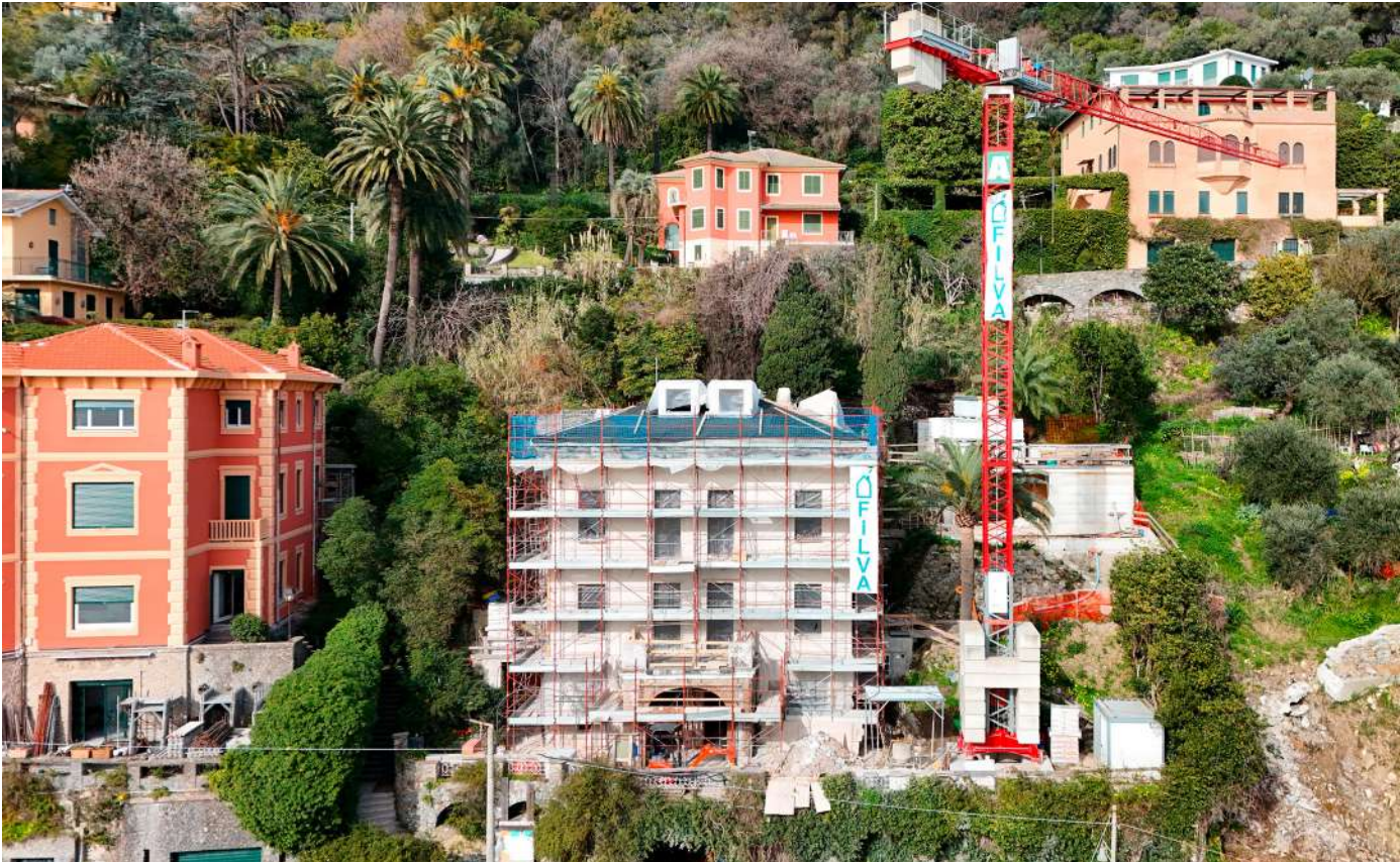
Stato avanzamento lavori - vista dall'alto
